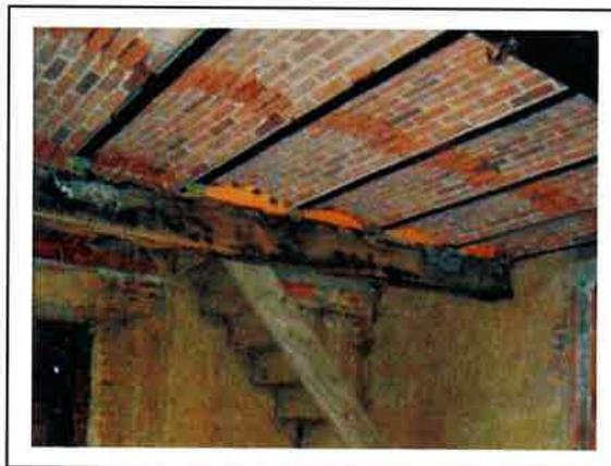
Les anciennes voussures n'ont pu être sauvées : les voussettes actuelles sont des tôles galvanisées, cintrées, habillées de plaquettes de briques, vendues comme faux plafonds. C'est un prototype car elles servent ici de coffrage perdu pour la dalle de béton armé de l'étage, dalle qui tient dorénavant toute la maison ensemble.
